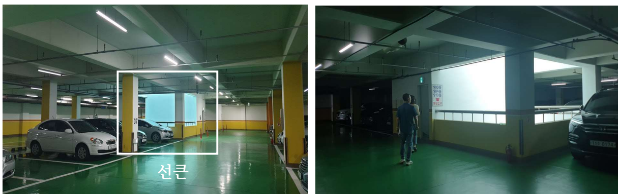
<그림 23> 선큰이 설치된 지하주차장
