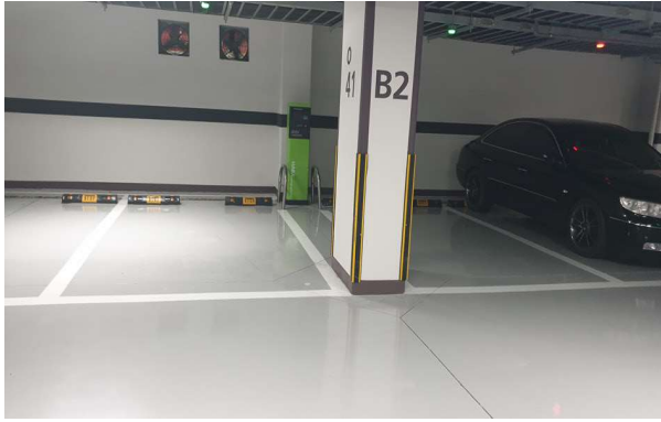
<그림 30> 충전구역 표시를 하지 않은 예시(좌), 충전구역 표시기준과 다른 색상(우)
